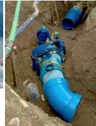
Bau einer Wasserleitung
