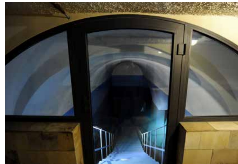
Blick in die Wasserkammer
